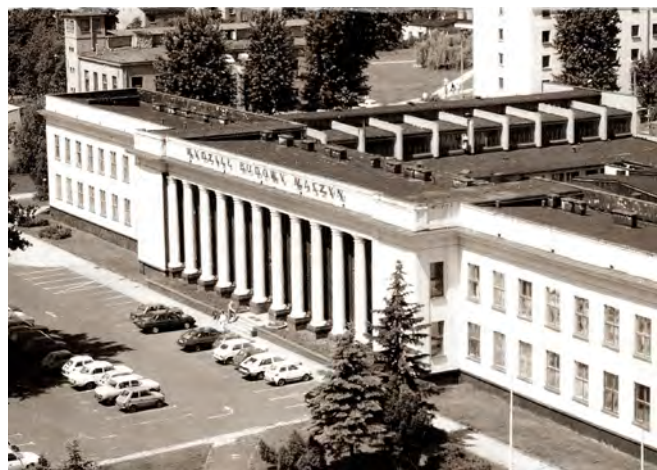
Budynek Wydziału Budowy Maszyn (1980)
